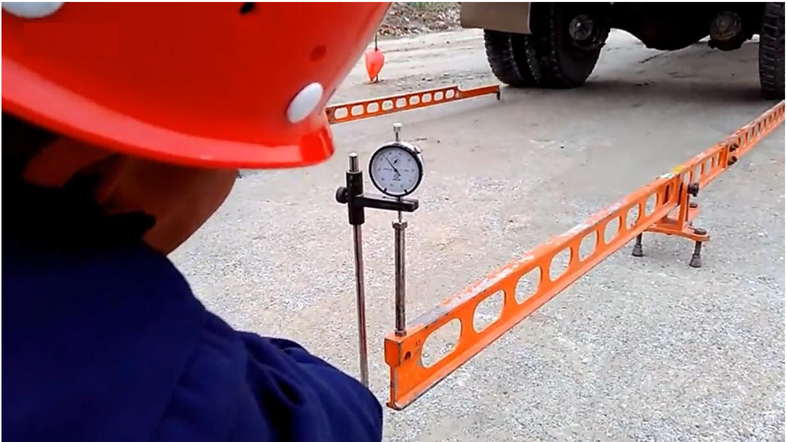
路基弯沉值测定试验
